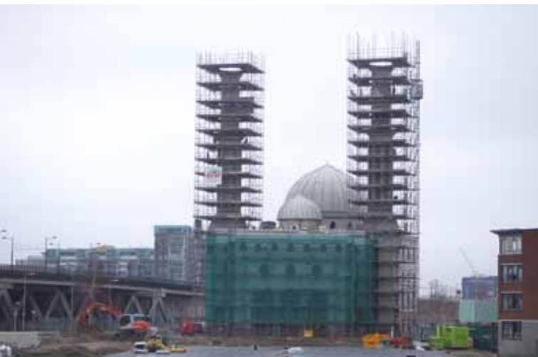
Bouw van moskee in Rotterdam
